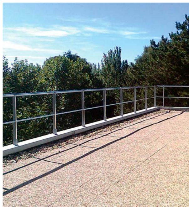
Parapetto dritto fissaggio in piano.
